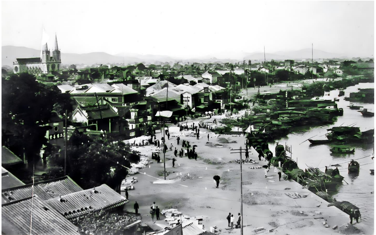
最初修筑的长堤
