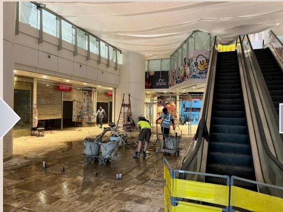
全天候修復工程
