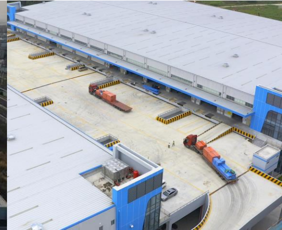
佛山物流倉儲設施
