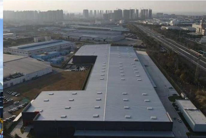
常熟南物流倉儲設施
